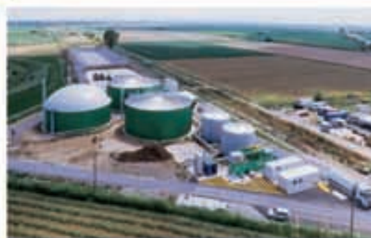
Έργα Βιοαερίου &amp; Διαχείρισης Απορριμμάτων
