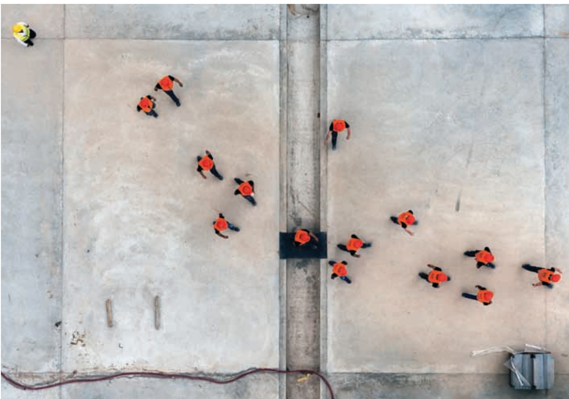
Κανάλι, σκυρόδεμα κοίτης, κατασκευα- στικοί αρμοί
