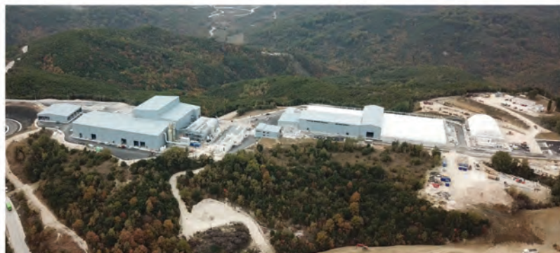
Μονάδα Διαχείρισης Απορριμμάτων Ηλείου
