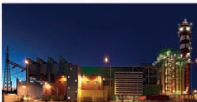
ΗΡΘΝ, Σταθμοί Ηλεκτροπαραγωγής
