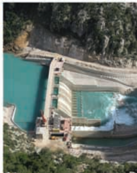
Υδροηλεκτρικό Έργο Δαφνοζωνάρας
