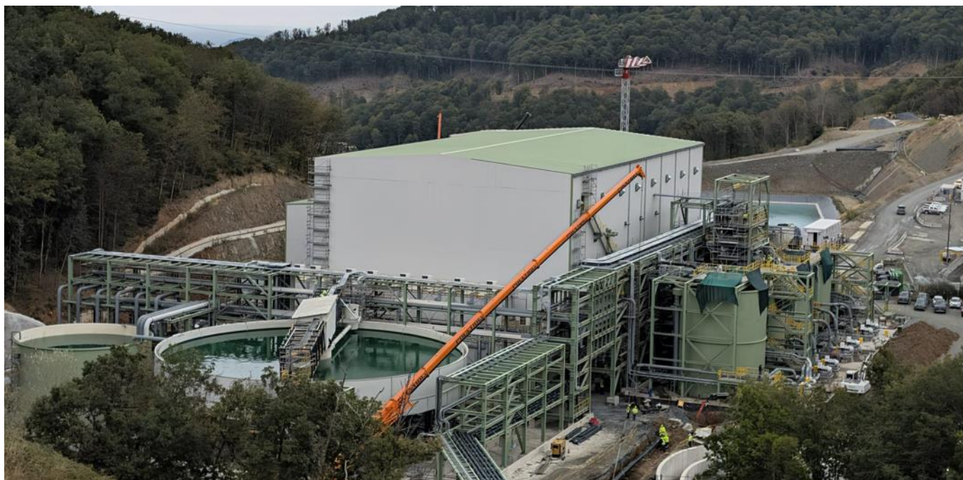
Εγκατάσταση αφυγρασμένων (φιλτραρισμένων) μεταλλευτικών καταλοίπων
