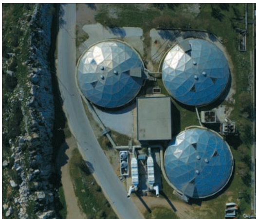
Κέντρο Επεξεργασίας Λυμάτων Ψυττάλειας
