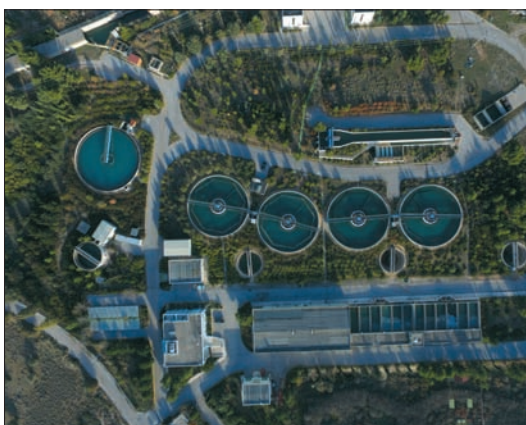
Μονάδα Επεξεργασίας Νερού Ασπροπύργου
