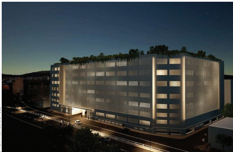
Πρώην εργοστάσιο Κεράνη
