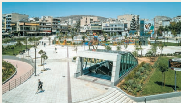
Σταθμός Κορυδαλλός, Μετρό Αθηνών Γραμμή 3
