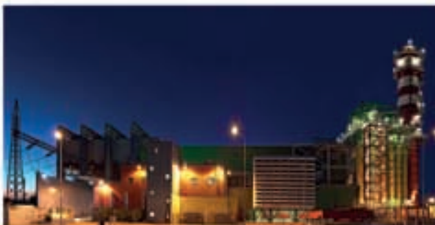
ΗΡΘΝ, Σταθμοί Ηλεκτροπαραγωγής
