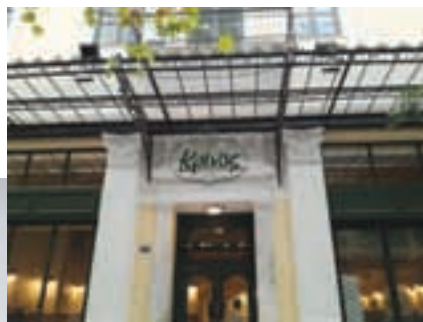
Εδώ στεγάστηκε το πρώτο φαρμακείο της πόλης
